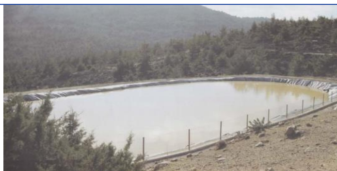
Η λιμνοδεξαμενή στη θέση Αρβανίτισσα Καρυές- Χίος
